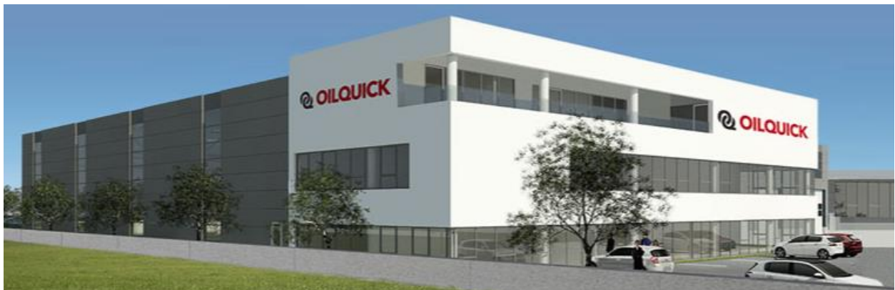
Abbildung 7: Verwaltungsgebäude / Produktionshalle Bau Fertigstellung 2020
